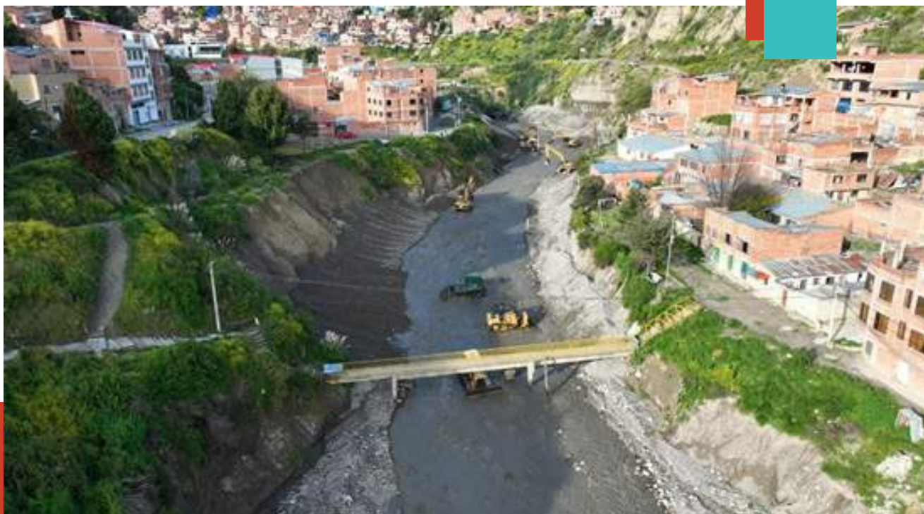
Fotografía. Río Orkojahuirá (Zona Villa Lobos Municipal) – Intervención con maquinaria para la protección de taludes y obras especiales (pasarelas, viaductos) en ambos márgenes hidráulicos. Se realizó la reconformación de camellones y encauce del río.
