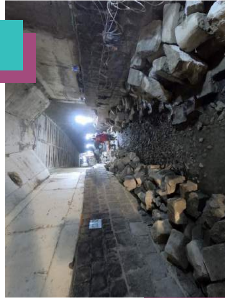
Fotografía: Reparación embovedado río Choqueyapu
