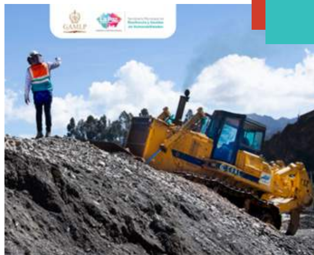
Fotografía. Personal de la SMRGV realizando trabajos.
