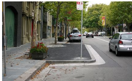
Ejemplo de «oreja» que permite estrechar una calle, delimitar el estacionamiento, mejorar la visibilidad y reducir los cruces peatonales
