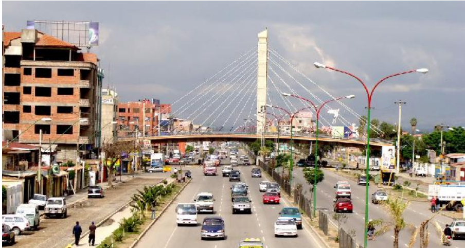
Puente a desnivel en Cochabamba.
