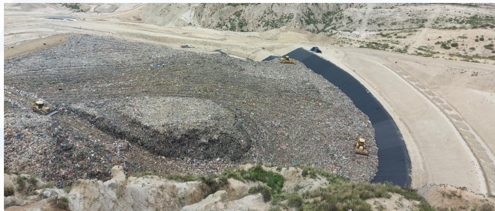
Compactación en el sector
