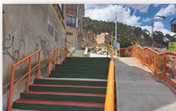
RECONSTRUCCIÓN GRADERÍAS Y OBRAS COMPLEMENTARIAS - PERIFÉRICA
