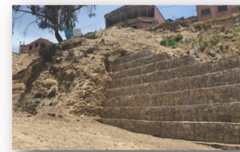
ESTABILIZACIÓN CON MURO DE GAVIONES MAX PAREDES
