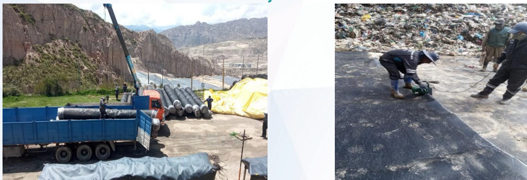
Materiales y trabajos de impermeabilización
