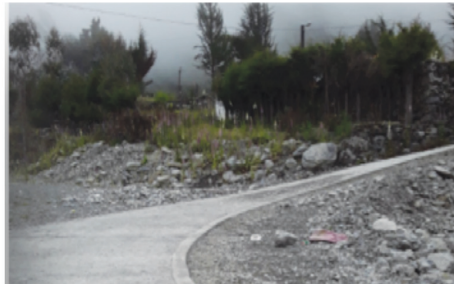
MEJORAMIENTO VIAL ENTRE PROGRESIVA 0+030 A 0+000 DE ACCESO A LA COMUNIDAD CUTICUCHO
