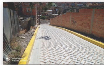
ENLOSETADO Y OBRAS COMPLEMENTARIAS SUR
