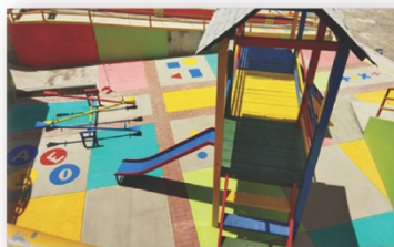
RECONSTRUCCIÓN ÁREA RECREATIVA MAX PAREDES
